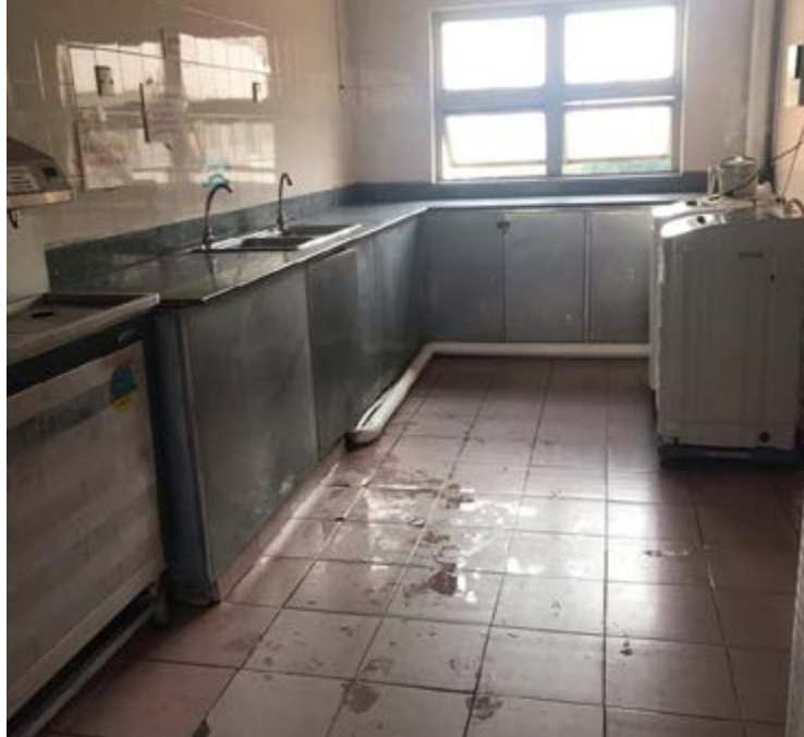
Buanderie dans le bâtiment où sont logées les ouvrières.
